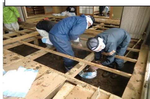
泥は柔らかく、手ですくって、バケツ（土のう袋）に入れました
