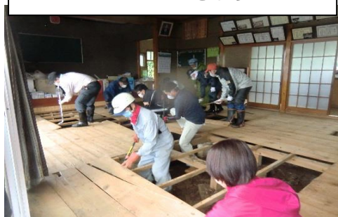
泥出しをするために床板をはがしていきます
